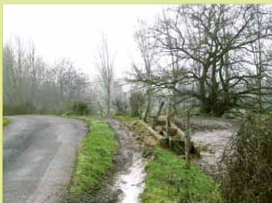
*L'accotement est dégradé, d'où l'affaissement des bas côtés et le non écoulement des eaux.*
