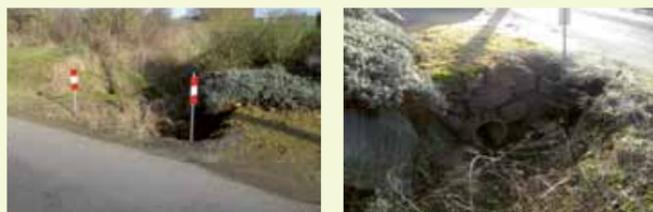
Après travaux : prolongation de la buse, mise en œuvre de remblai au-dessus de la buse pour sécurisation, réalisation d'une descente en béton avec grille pour récupération des eaux de la voie communale.
