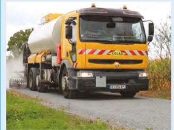
Des travaux spécifiques ont par ailleurs été réalisés sur des zones très abîmées et des chemins jusqu'alors non revêtus. Dans ces cas, les voies ont été structurées grâce à un rechargement puis la pose d'enduits et de gravillons (6 750 m<sup>2</sup>). Au total, ces chantiers ont coûté environ 290 000 € TTC. Retrouvez en vidéo un reportage sur notre page Facebook.
